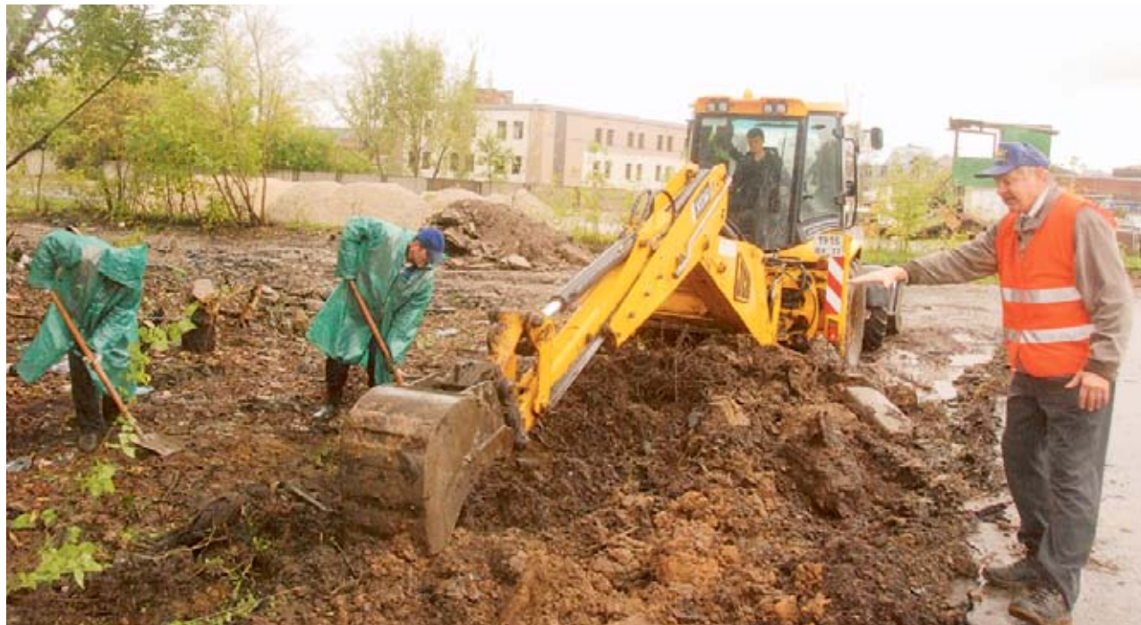
Михаил Шаманин в любую погоду на площадке
