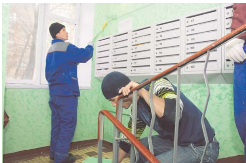
В районе закончен ремонт подъездов
