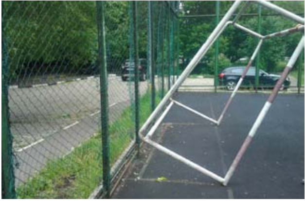
Улица 3-я Гражданская, дом 3. На спортивной площадке не закреплены футбольные ворота
